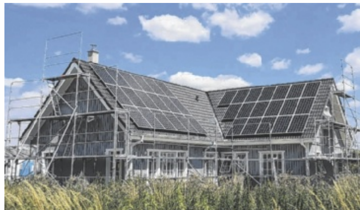
Dachflächen bieten riesiges Potential für die Nutzung von Sonnenenergie.
